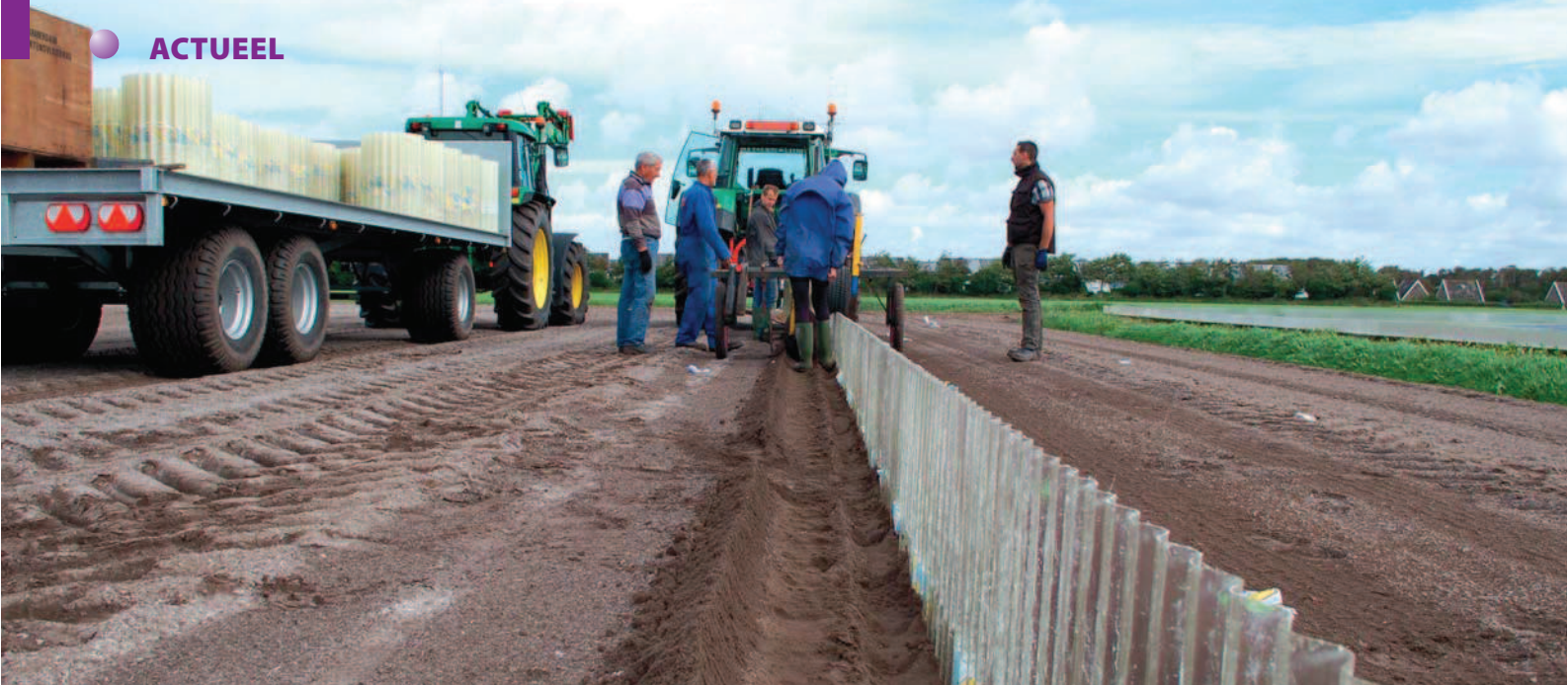
Kunststof golfplaten vervangen de zanddijkjes rondom een inundatieperceel
